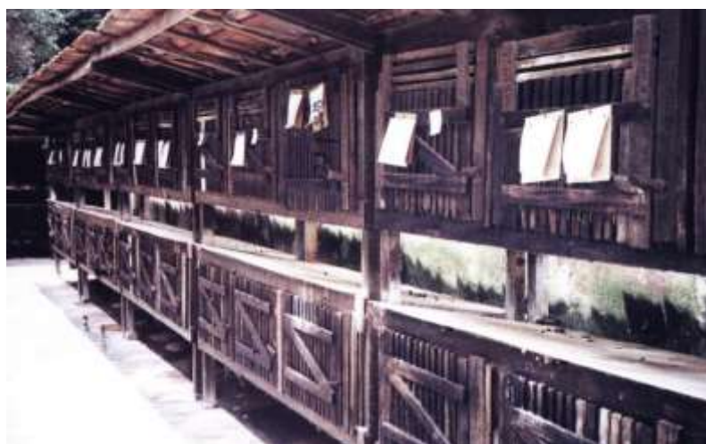
Figura 15 – Gaiolas ao ar livre, construídas em madeira, em dois níveis.
