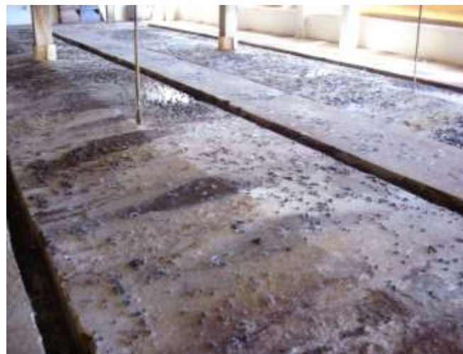
Figura 03 – Piso de cimento, com declive lateral, com duas valas para escoar os líquidos. Fonte: Arquivo pessoal.
